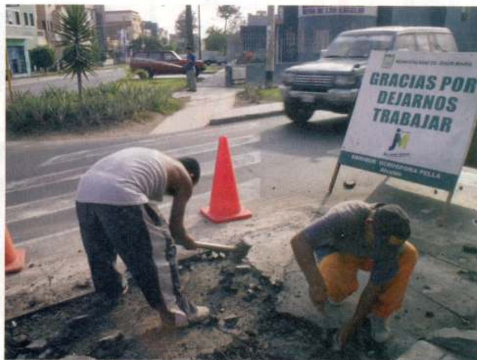
Pistas rotas y en mal estado. La actual gestión está colocando nueva carpeta asfáltica en toda la zona.
