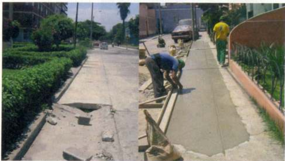
Las pistas y veredas están siendo rehabilitadas, mejorando el ornato para la comodidad de los vecinos.
